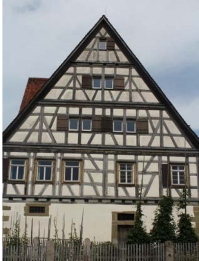
Die Westseite von Haus Öschelbronn wurde saniert.
