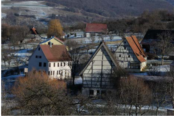
Die Winterzeit wird für Ausbesserungsarbeiten genutzt.
