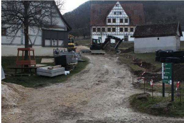
Bis vor kurzem wurde am Weg noch emsig gearbeitet
