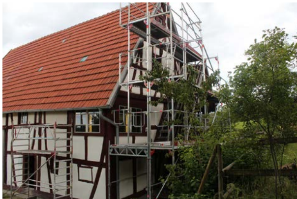
Das Bauernhaus aus Aichelau ist derzeit eingerüstet. Die Außenfassade wird renoviert.
